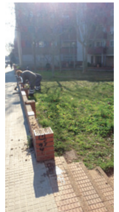
Obres a l'avinguda del Cantàbric
