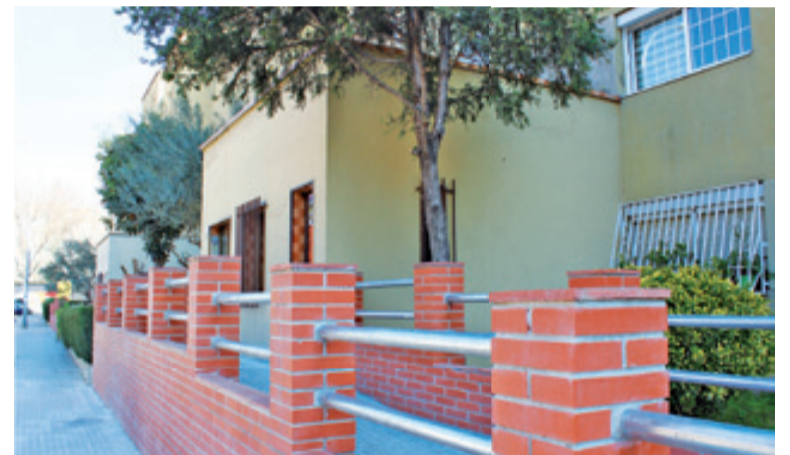
El c. de la Bètica núm. 5, un cop finalitzades les obres
