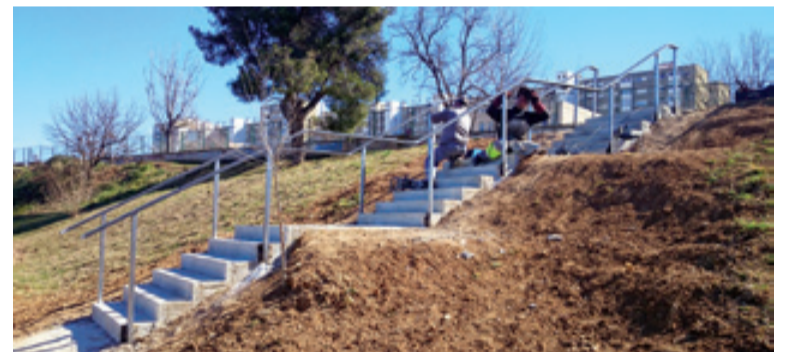
Construcció d'unes escales al camí que va a l'Ikea
