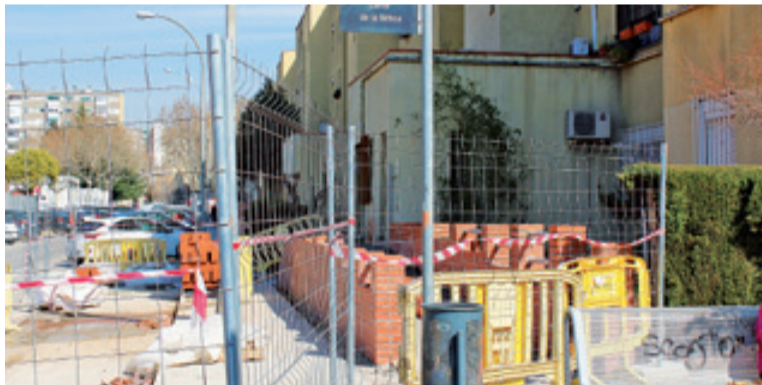
Obres de supressió de barreres arquitectòniques al c. de la Bètica
