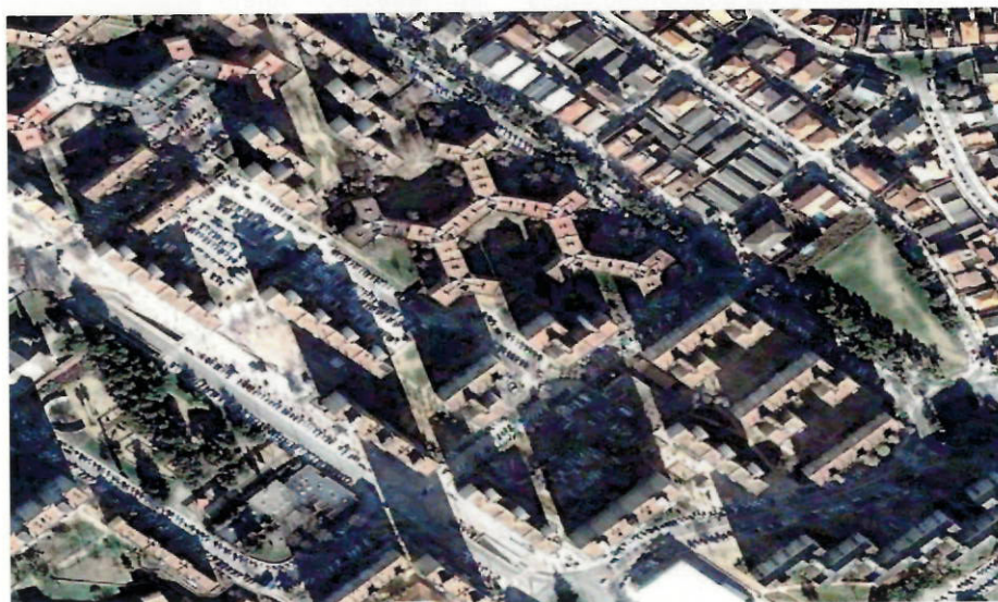
Vista aérea de la calle Zaragoza
